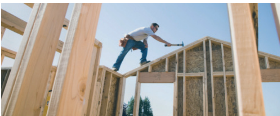
Bauüberwachung und Qualitätssicherung: Der Einsatz von Experten bringt Sicherheit
